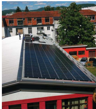
Слика 2: Реконструкција крова Централне котларнице Слика 3: Радови на инсталирању ФЕ
