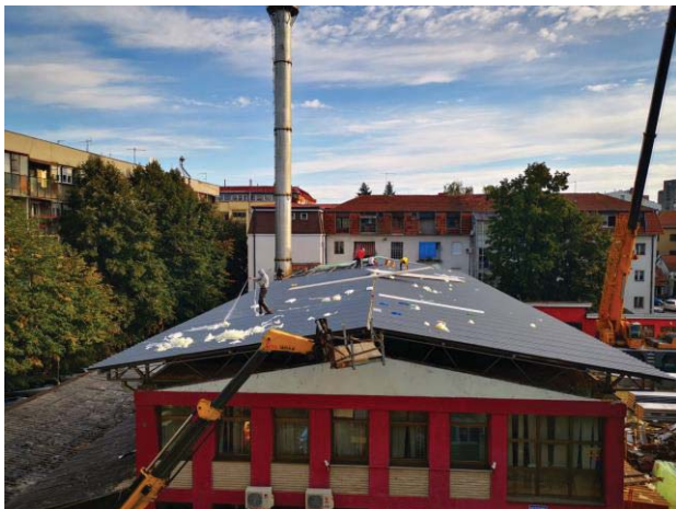
Слика 2: Реконструкција крова Централне котларнице Слика 3: Радови на инсталирању ФЕ
