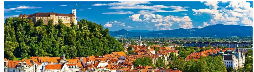
Energetska obnova u Opštini Ljubljana
